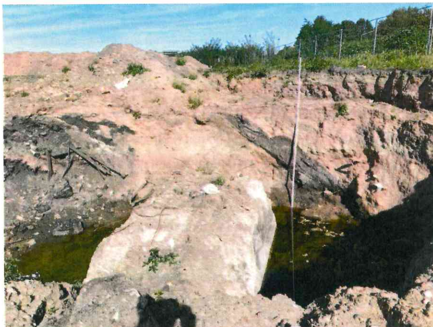
Abbildung 6: Fundament 2: Die heterogen zusammengesetzten Auffüllungen erstrecken sich bis in die gesättigte Bodenzone bzw. ist hier nach [5] eine Auffüllungsmächtigkeit von ca. \geq 6,0 m vorauszusetzen. Blickrichtung: Nordost; Aufnahmedatum: 28.07.2023.
