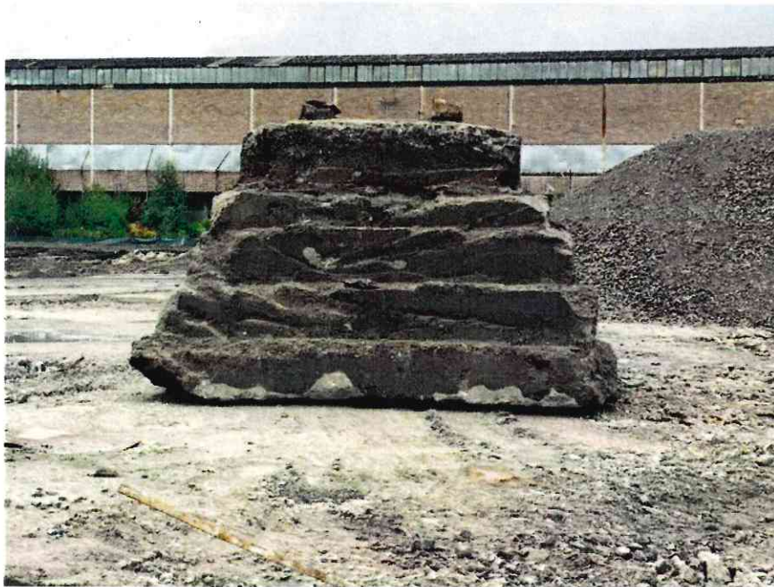
Abbildung 7: Blick auf ein im nordwestlichen Bereich der Projektfläche ausgebautes Fundament. Der pyramidenartige Aufbau wurde - mit sehr deutlich größeren Volumina - auch bei den Fundamenten der ehem. Kranbahn umgesetzt. Blickrichtung: Nordwest; Aufnahmedatum: 28.07.2023.
