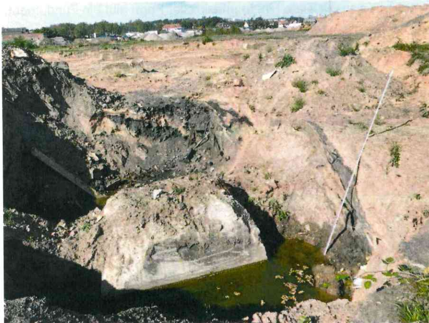
Abbildung 5: Blick auf das Fundament 2. Der Flurabstand des Grundwassers betrug - bezogen auf die ursprüngliche Geländeoberkante - am 28.07.2023 ca. 4,2 m. Im Bildhintergrund weitere Einzelfundamente der Reihe. Blickrichtung: Nordnordwest.
