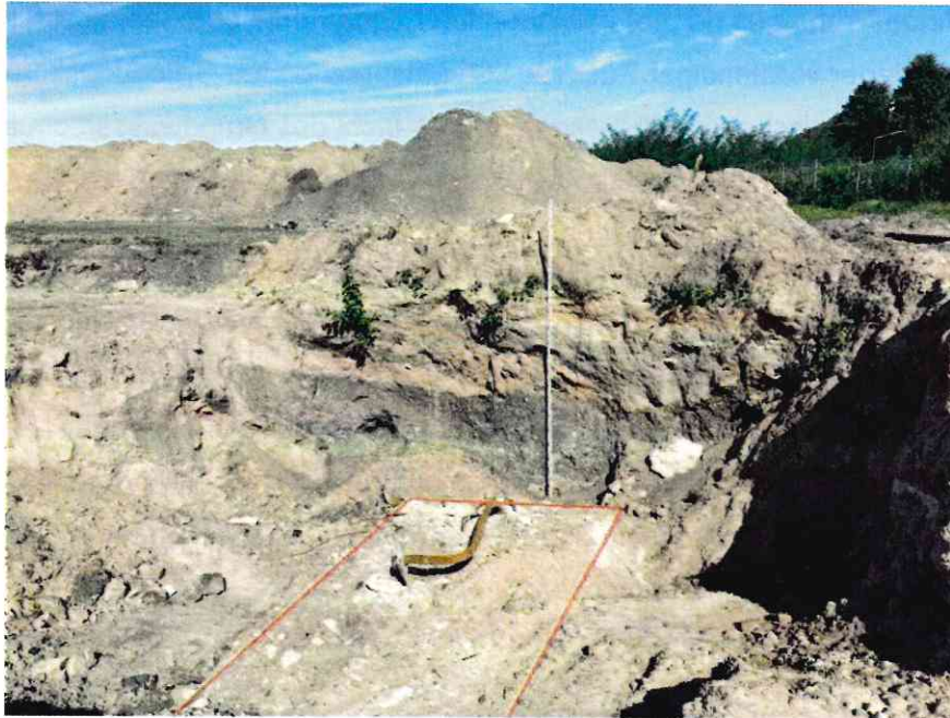
Abbildung 3: Bis in eine Tiefe von ca. 3,5 m unter der Geländeoberkante freigelegtes Fundament 1 (Abmessungen in dieser Tiefe ca. 4,0 m * 3,0 m). Blickrichtung: Nordost; Aufnahmedatum: 28.07.2023.
