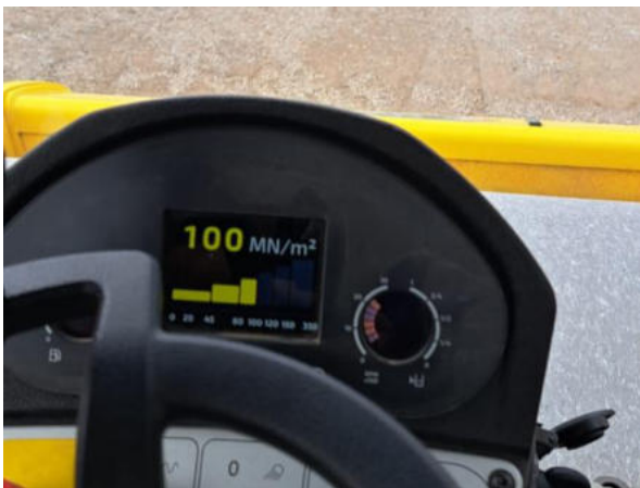
Bild 7: Verdichtung der Schottertragschicht (Foto: M. Beckert, Aufnahmedatum: unbekannt).
