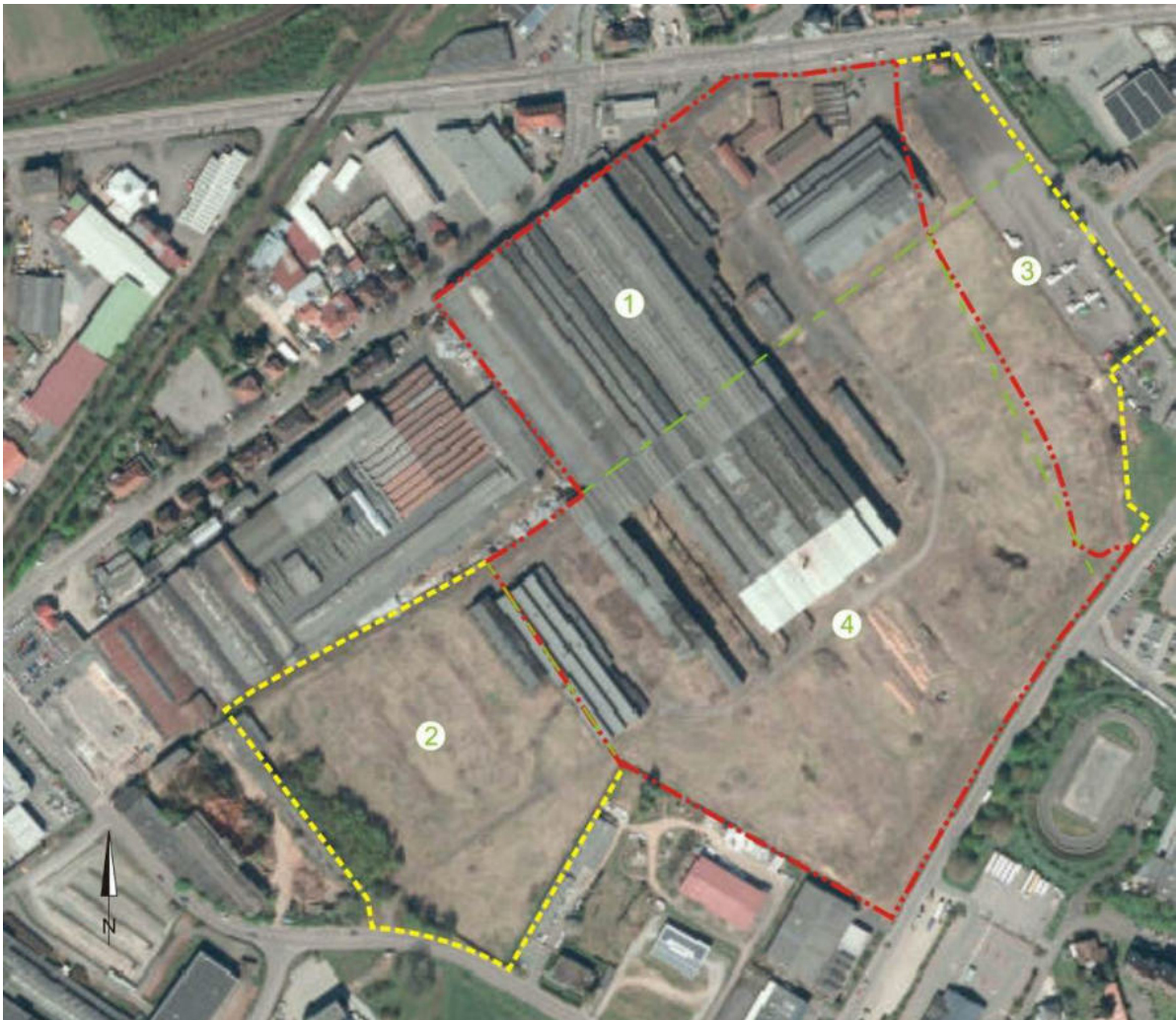
Abbildung 3: Projektion der Teilflächen des 1. Bauabschnitts (gelbe Begrenzungslinien) sowie des 2. Bauabschnitts (rote Begrenzungslinien) in ein Luftbild (Aufnahme vor dem Rückbau des Anlagen- und Gebäudebestands; ohne Maßstab). Nummern 1 bis 4: Nutzungsbereiche gemäß Sanierungsplan [6].
