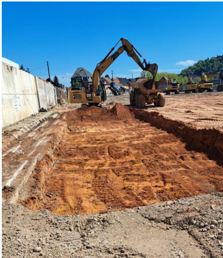
Bild 5: Abtrag von Bodenmaterial (Foto: M. Beckert, Aufnahmedatum: unbekannt).
